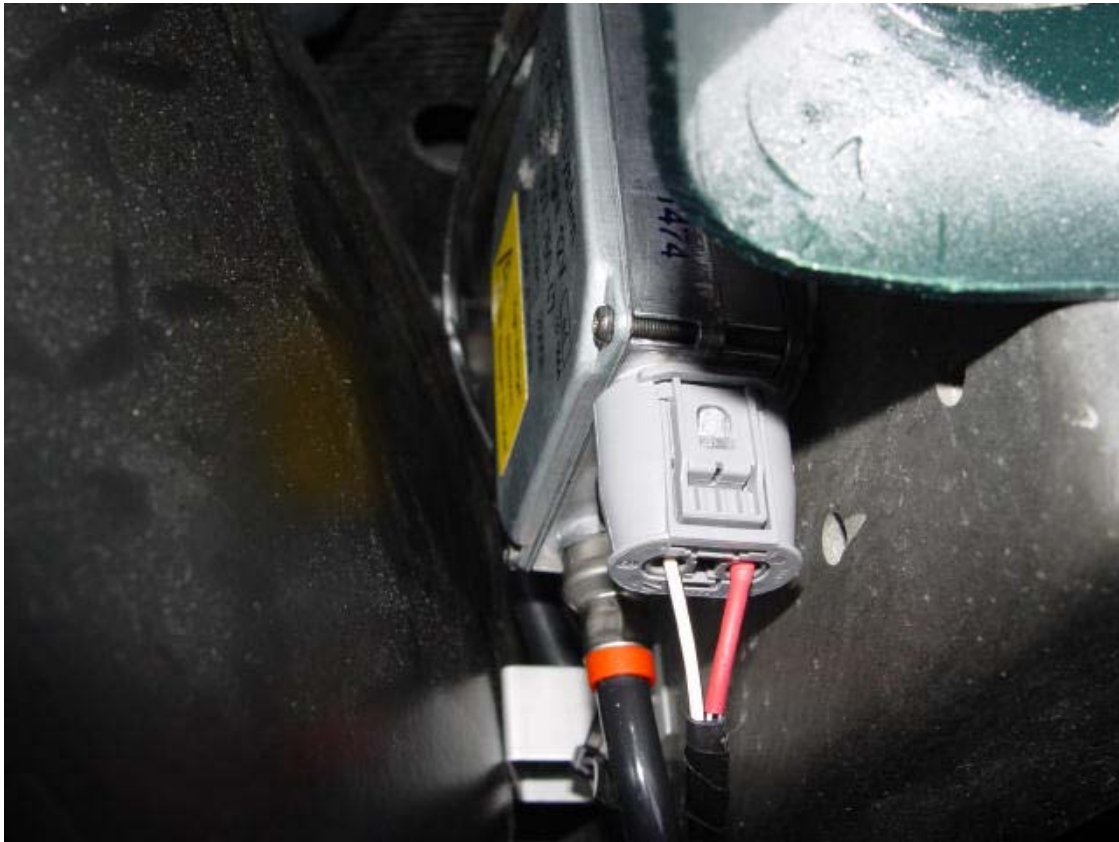
Foto 11. Ballast in situ.
